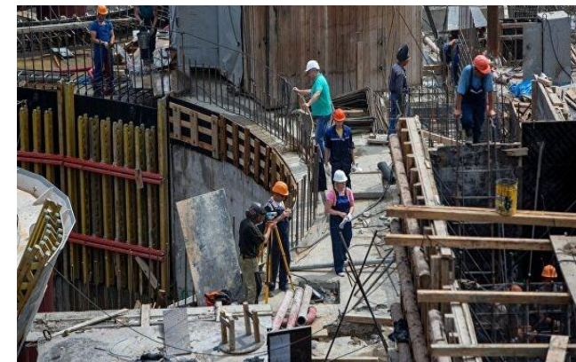
В ходе строительство ГЭС
