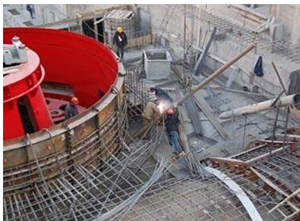
В ходе строительство ГЭС
