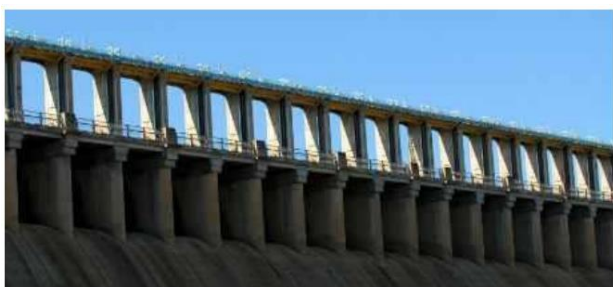
Рис.3.6. Контрфорсные плотины
