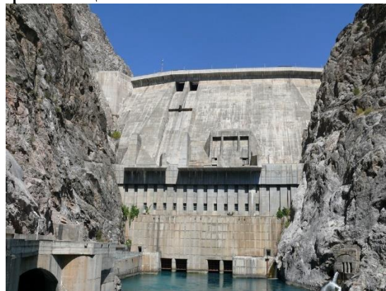
Рис.3.2. Гравитационная бетонная плотина
