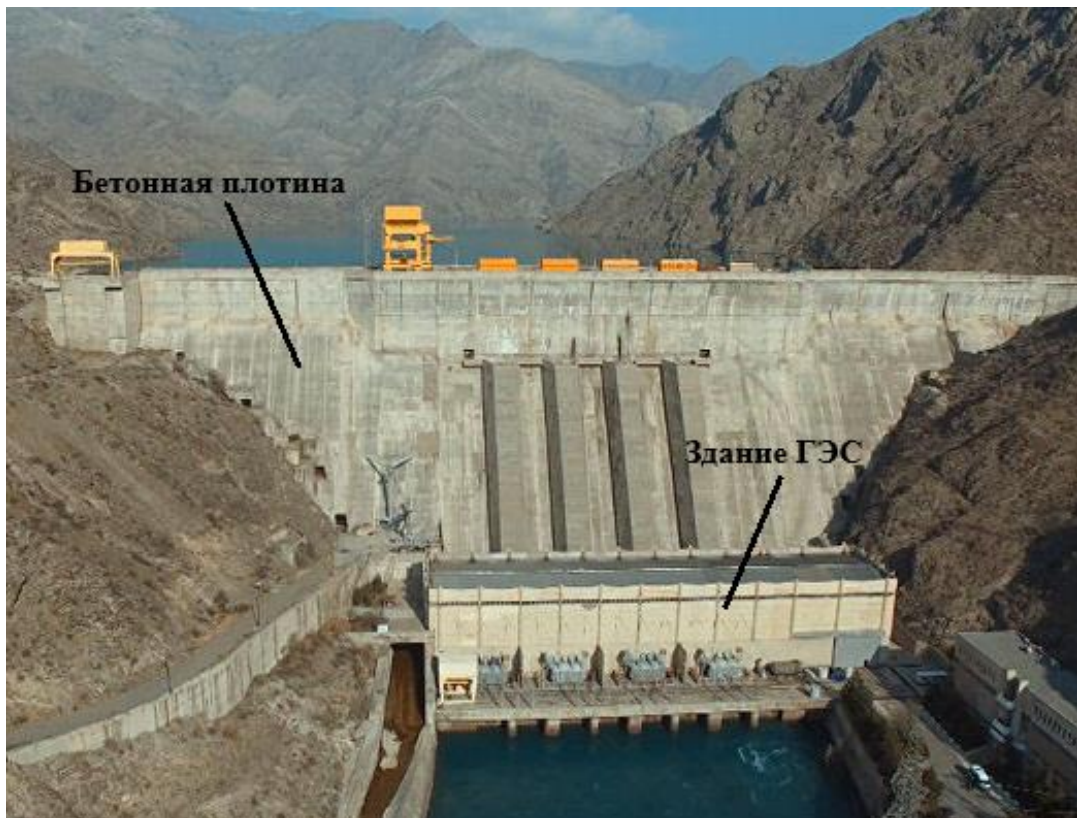
Рис.1.5. а) Русловая ГЭС (Шамалдысаяская ГЭС); б) ГЭС с водохранилищем (плотинная) Курпсайская ГЭС. Фото из CAWater-Info
