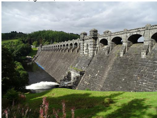
Рис.3.1. Гравитационная каменная плотина
