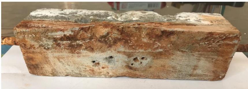
Рис. 4. Образец, подверженный электрокоррозии
