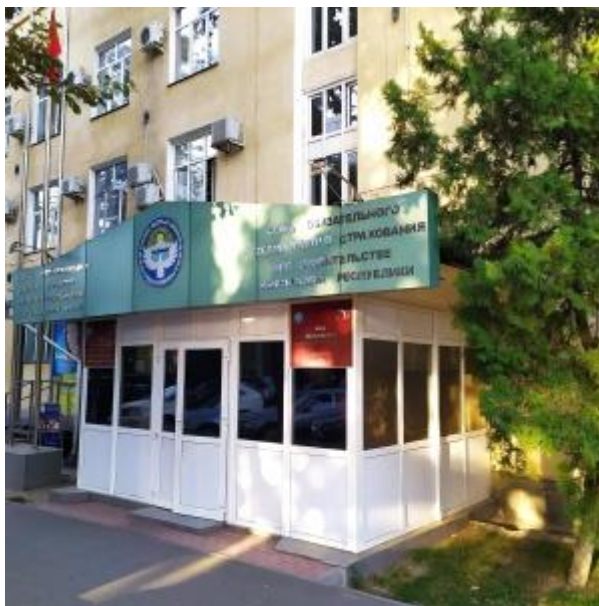
Рисунок 1. Главный корпус Центральный аппарат ФОМС
