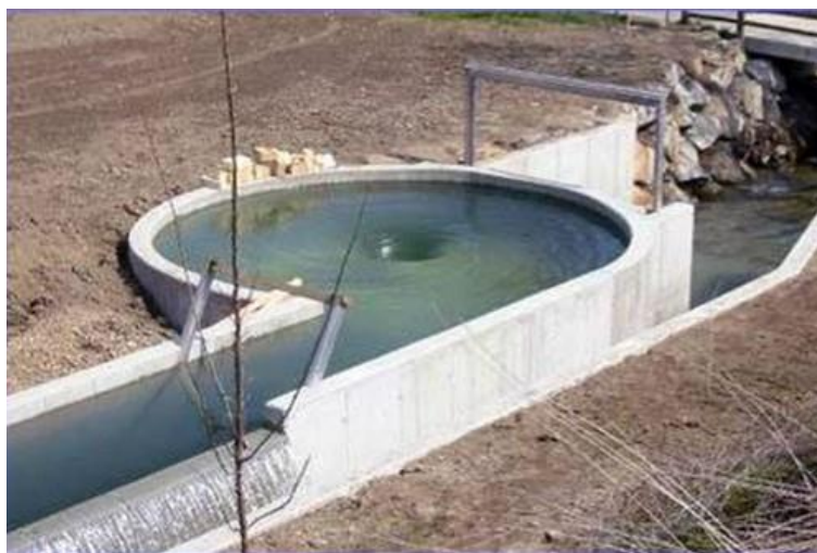
Рис. 1. Водоворотная Микро (ГЭС).
